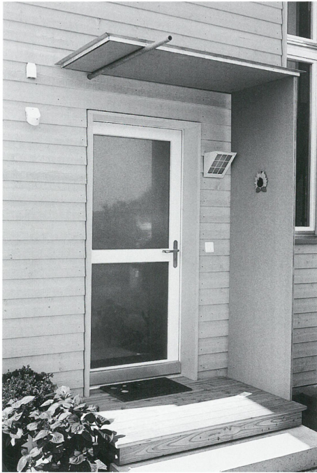
Geschossweise Montage der Fassade. Hauseingang auf der Nordseite.
