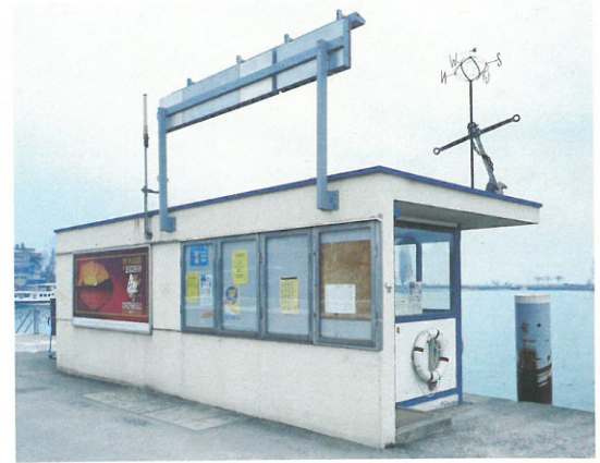
Romanshorn Baujahr: 1965 Funktion: Hafenmeisterbüro Architekt: Max Fehr, Zürich
